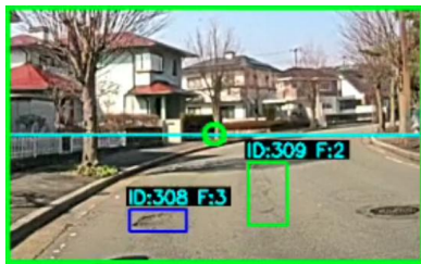
図 1 ,道路損傷箇所の検出画像
