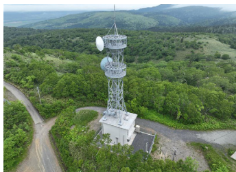
知駒無線中継所
