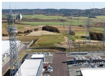
北豊富変電所
