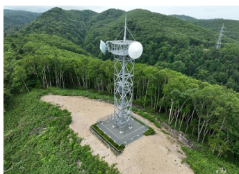
中川無線中継所
