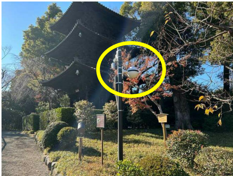
△庭園へ設置した Wi-Fi アクセスポイント 景観を考慮して球体タイプを選定して設置
