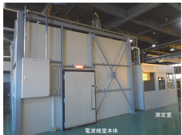
写真3 ハイブリット電波暗室外観
