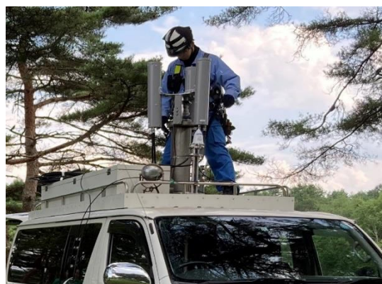
Sub6 帯アンテナ設置作業の様子
