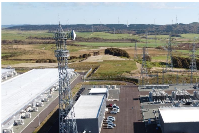
北豊富変電所
