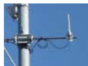
スリーブ型アンテナ 3バンドで地デジ帯域をカバー
