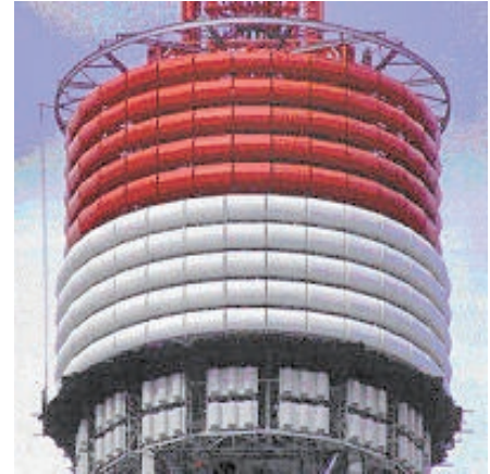
図1 東京タワーデジタル送信アンテナ
