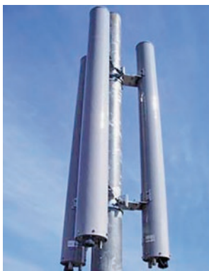
図 2.6.1 偏波共用アンテナ (給電部内蔵)
