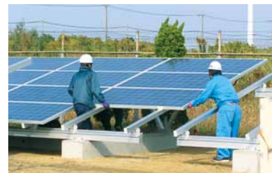
地中のアース線に細心の注意を払いながらパネルを設置します
