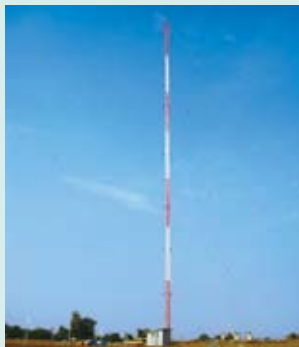
中波ラジオアンテナ全景
